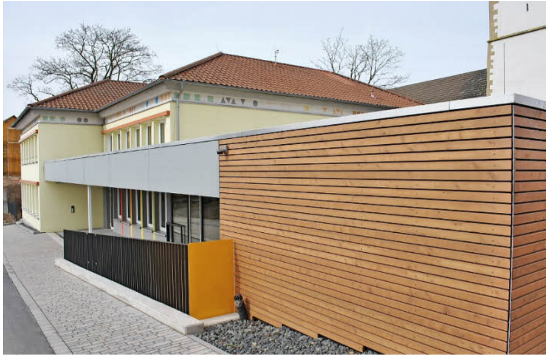
Der barrierefreie Eingangsbereich zur Kinderkrippe befindet sich an der Südseite des Gebäudes.
